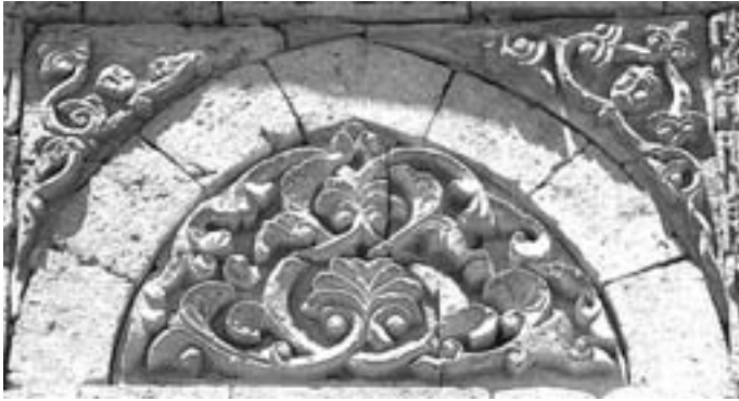
Resim 10. Güneydoğu cephe, güneyden ikinci kemer.
