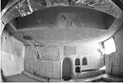
Resim 12. Sinasos Manastırı, Naos, Güney Duvar.
