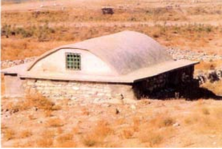
Fotoğraf:5 Türbenin güney cephesi
