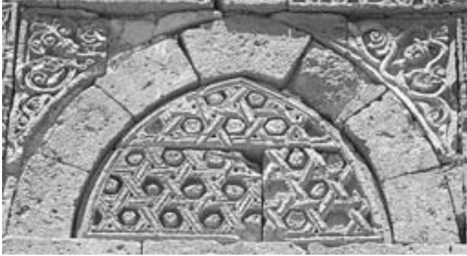
Resim 9. Güneydoğu cephe, güneyden birinci kemer.
