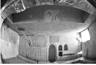
Resim 12. Sinasos Manastırı, Naos, Güney Duvar.
